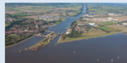
Schleusenanlagen des Nord-Ostsee-Kanals in Brunsbüttel
